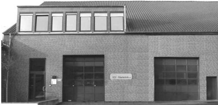
KSI Filtertechnik GmbH - Niederkrüchten
